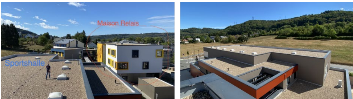
Abbildung 4: Dachflächen der Maison-Relais und der Sporthalle vor der Installation.
